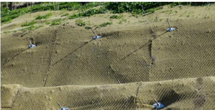
contra el talud o salientes cambien su trayectoria y caigan dentro de la calzada, encauzando su movimiento lentamente entre el talud y la malla hasta la parte inferior de este, donde se acumulará el material desprendido.
